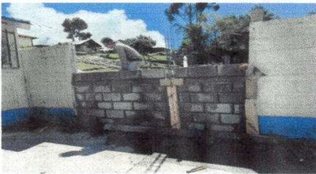
Foto 5: Reparación de muro perimetral
