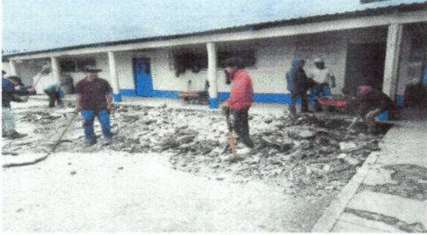
Foto 1: Estado actual del patio
