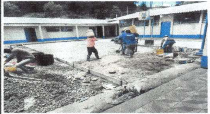
Foto 2: Estado actual del patio.
