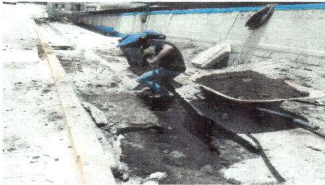
Foto 3: Estado actual del desagüe.
