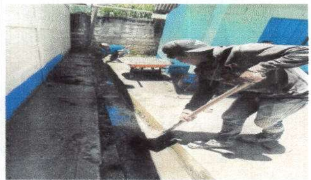
Foto 4: Estado actual del desagüe
